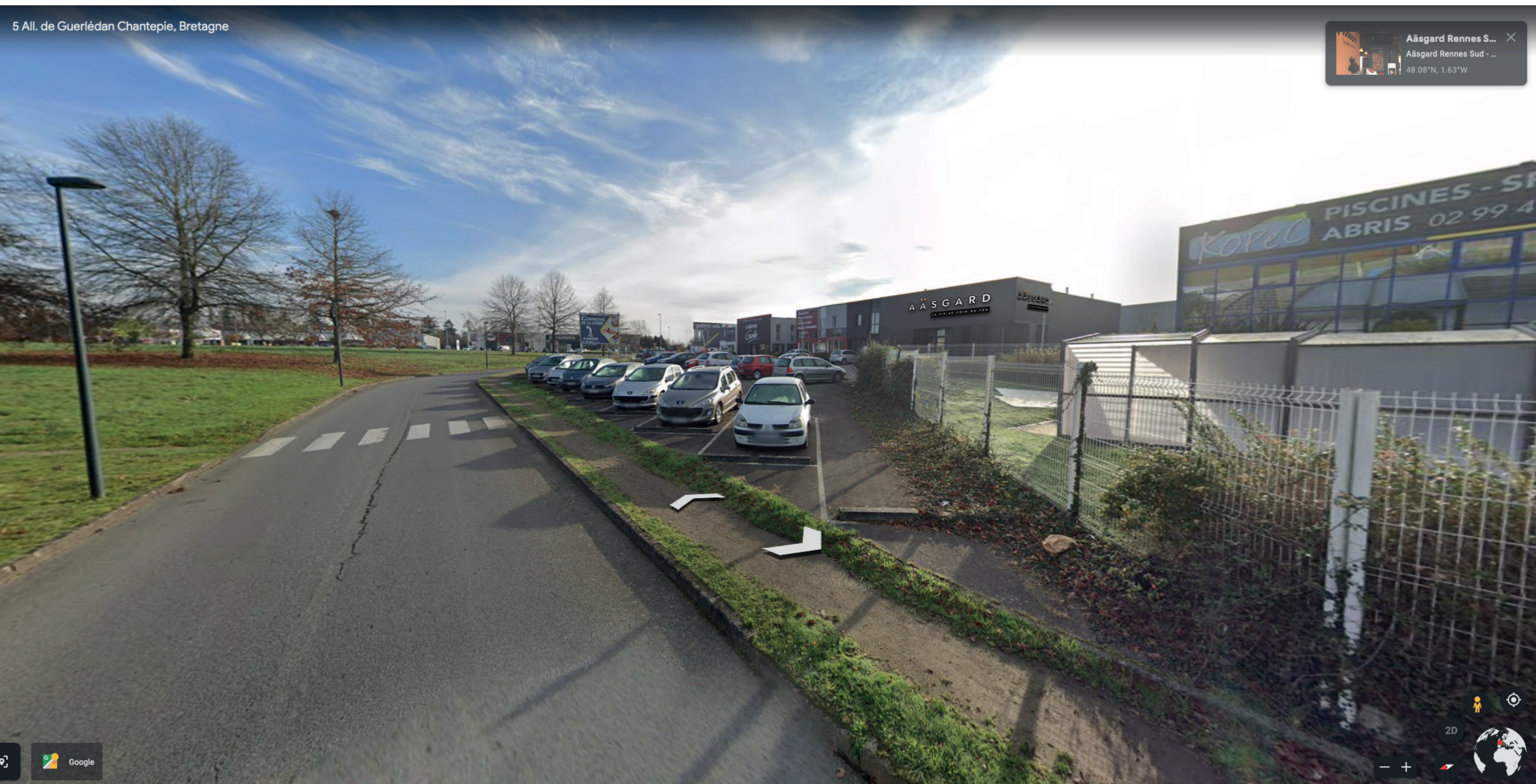
👁 Façade Nord-Ouets - All de Guerlédan -> direction sud-est
