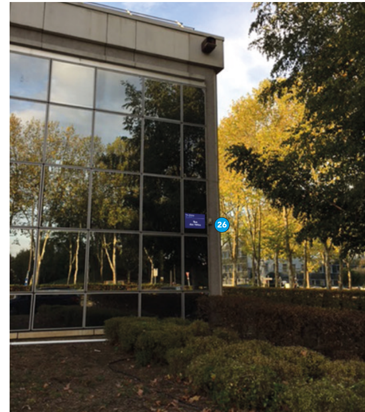
Bâtiment Rubens / Puce N°26 / Rue des Toiles
