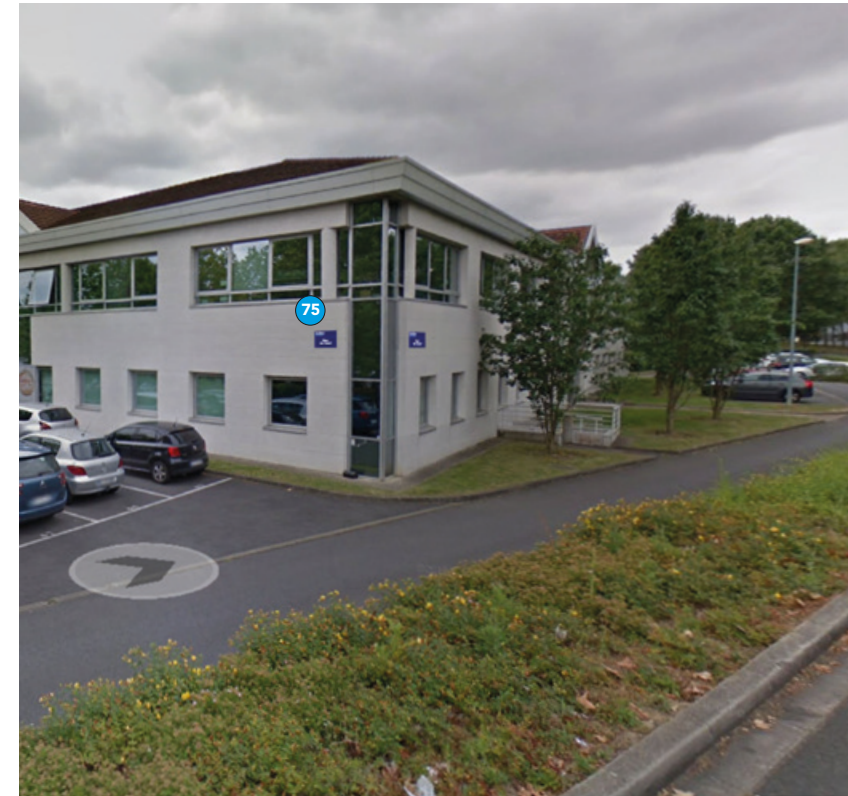
Bâtiment Niagara / Puce N°75 / Rue du Canal
