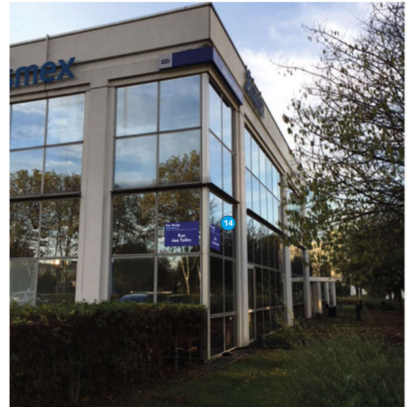
Bâtiment Raphaël / Puce N°14 / Rue du Chevalet
