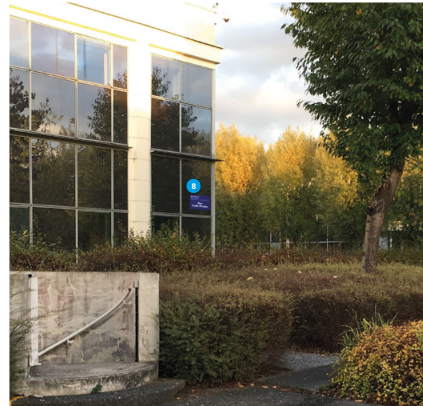
Bâtiment Rembrandt / Puce N°8 / Rue Pablo Picasso
