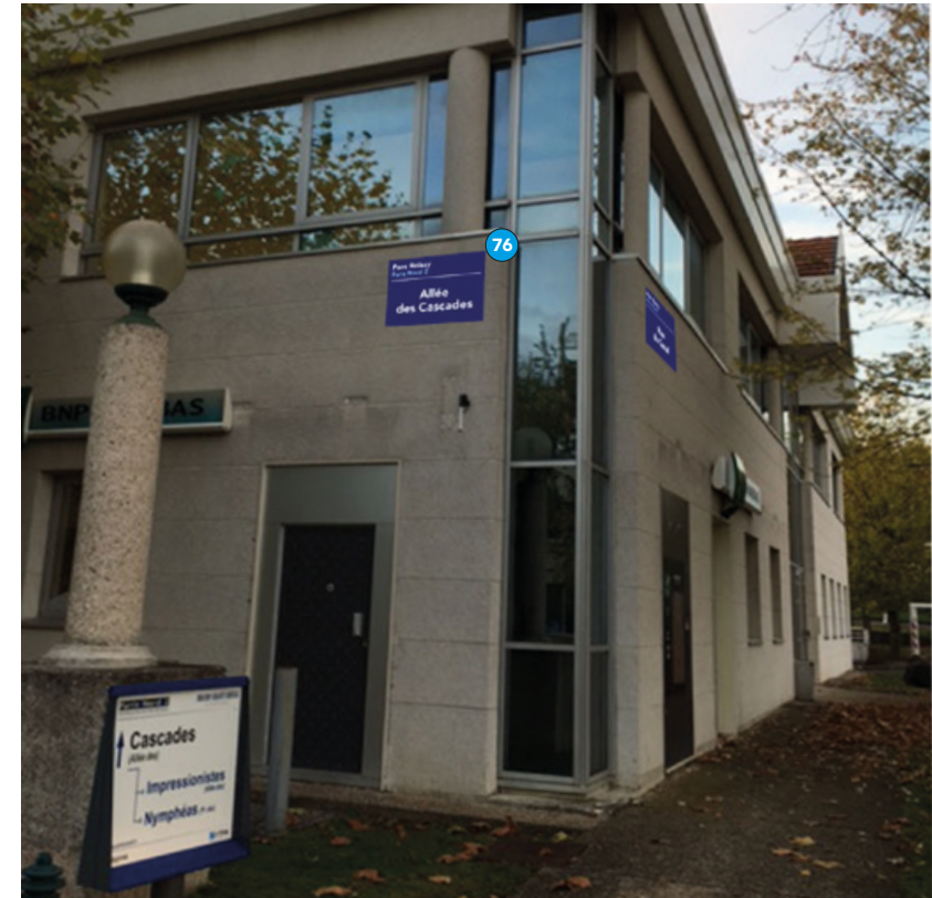
Bâtiment Victoria / Puce N°76 / Allée des Cascades
