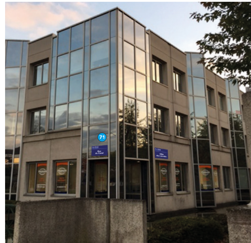
Bâtiment Deltaparc / Puce N°71 / Rue du Canal
