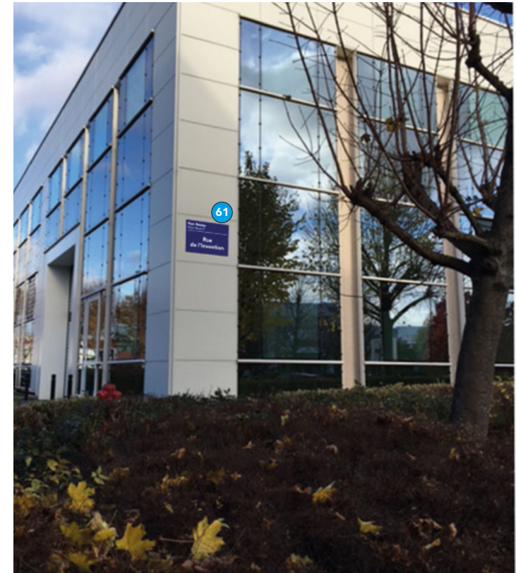
Bâtiment Euler / Puce N°61 / Rue de l'Invention
