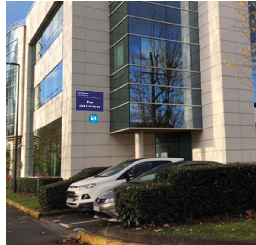
Bâtiment Edison / Puce N°54 / Rue des Lumières
