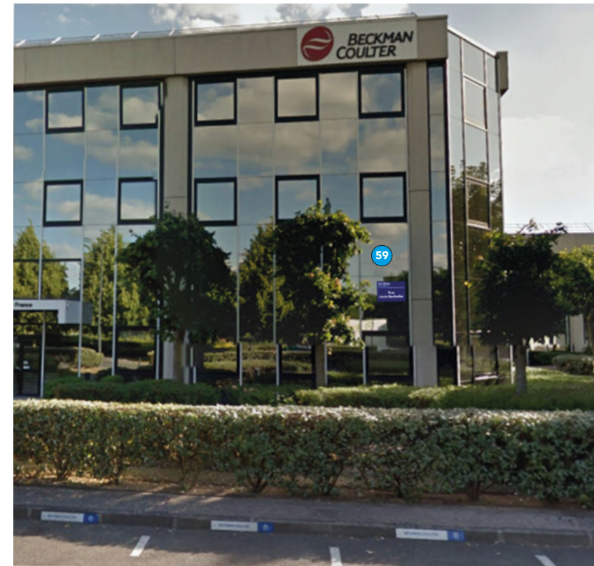
Bâtiment Euclide / Puce N°59 / Rue des Lumières
