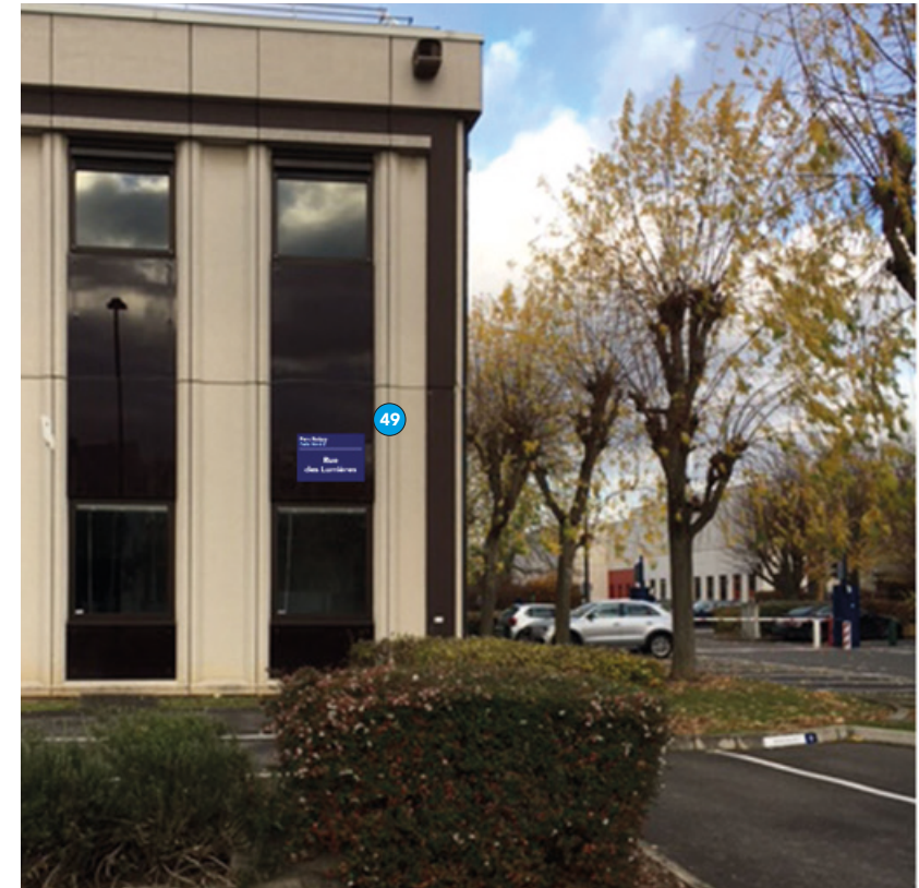
Bâtiment Eole / Puce N°49 / Rue des Lumières
