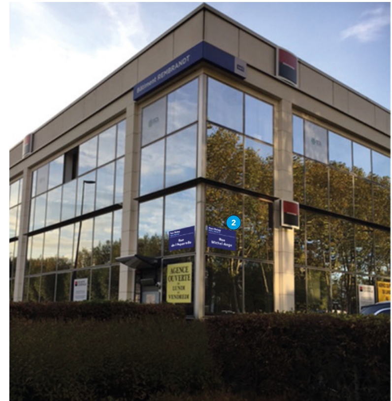
Bâtiment Rembrandt / Puce N°2 / Rue de Michel Ange
