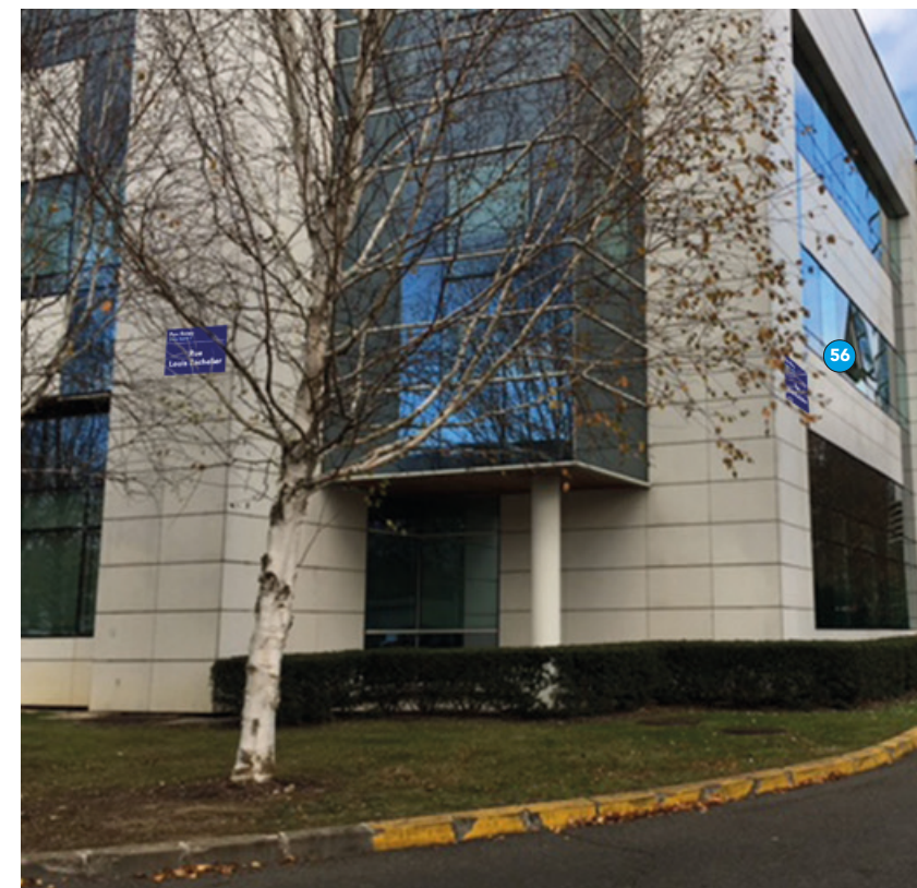
Bâtiment Exelmans / Puce N°56 / Rue des Lumières
