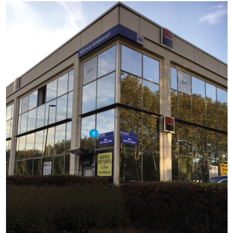
Bâtiment Rembrandt / Puce N°1 / Rue de l'Aquarelle
