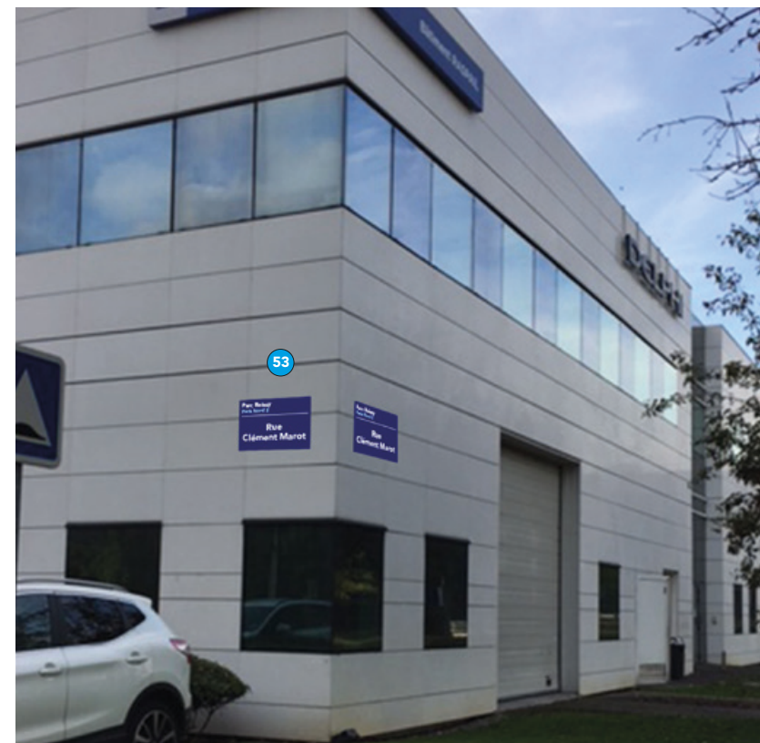
Bâtiment Edison / Puce N°53 / Rue des Lumières
