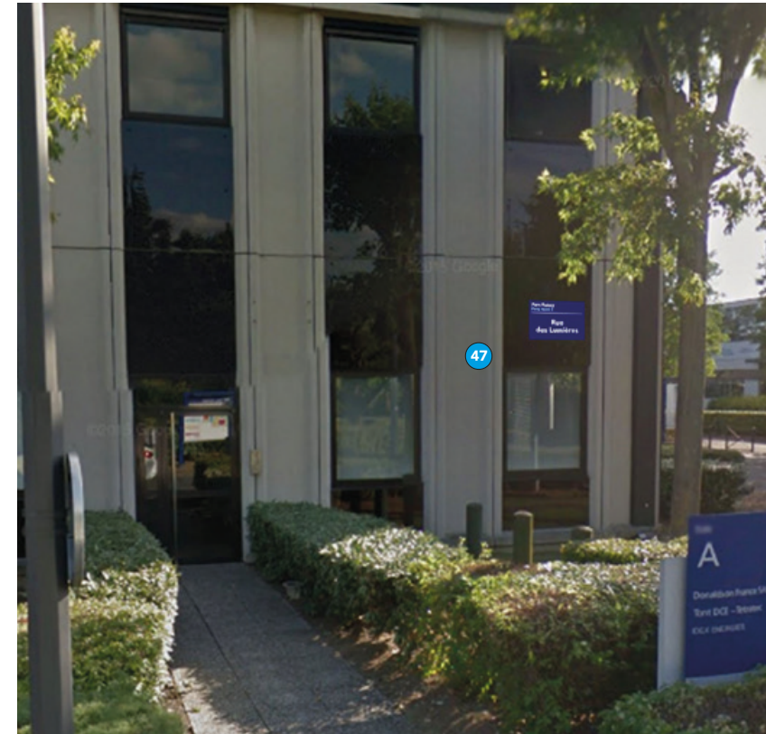
Bâtiment Eole / Puce N°47 / Rue des Lumières
