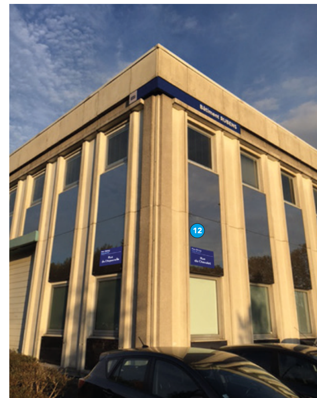
Bâtiment Rubens / Puce N°12 / Rue du Chevalet
