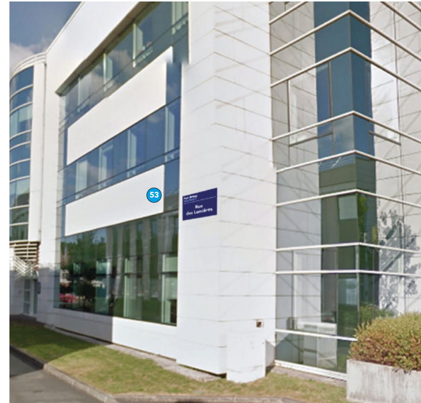
Bâtiment Edison / Puce N°53 / Rue des Lumières
