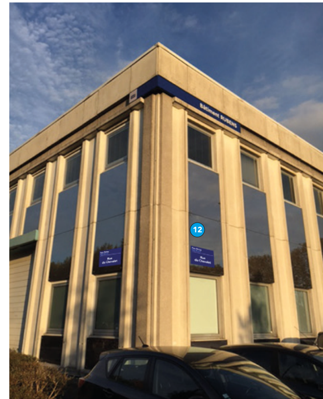
Bâtiment Rubens / Puce N°12 / Rue du Chevalet
