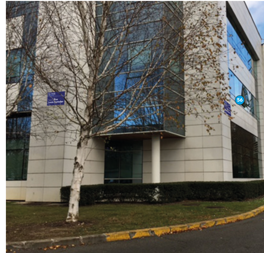
Bâtiment Exelmans / Puce N°56 / Rue des Lumières
