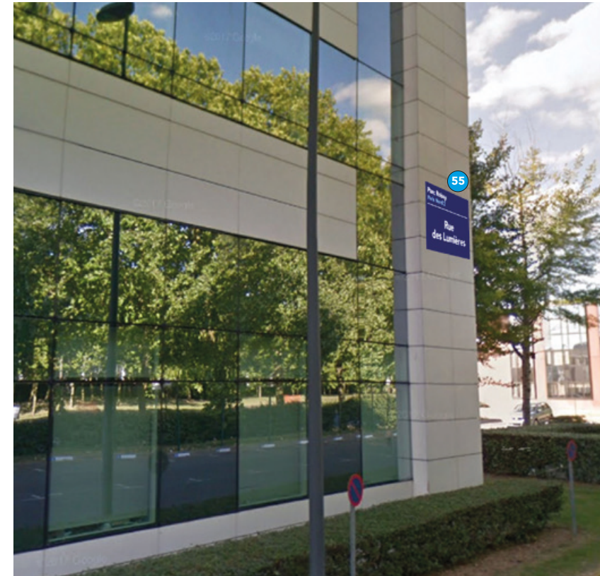
Bâtiment Edison / Puce N°55 / Rue des Lumières
