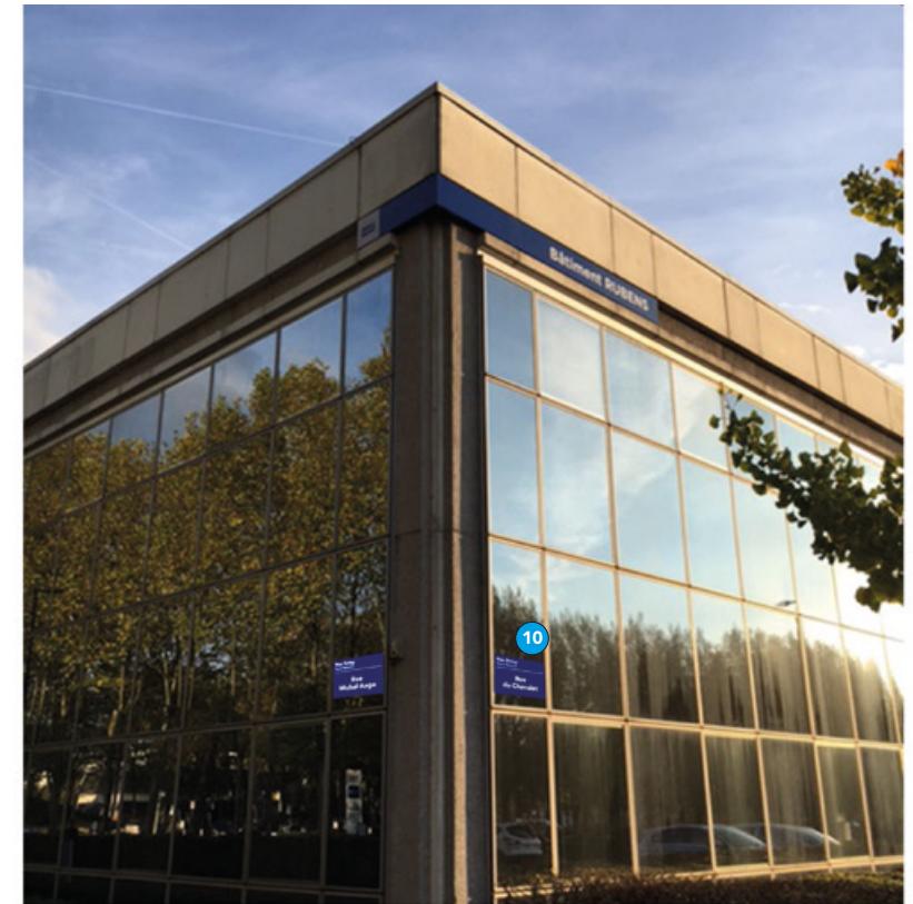
Bâtiment Rubens / Puce N°10 / Rue du Chevalet
