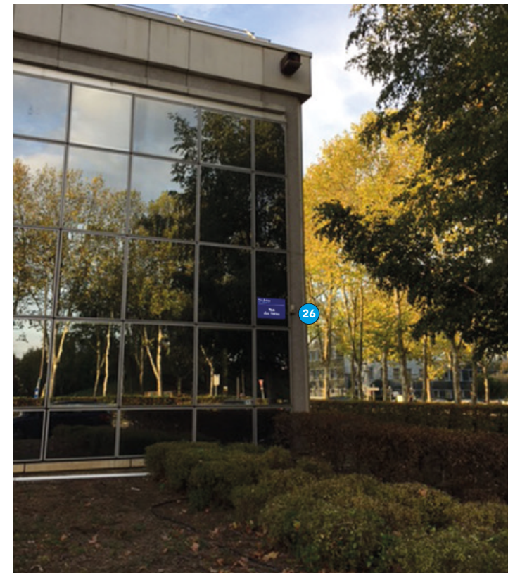
Bâtiment Rubens / Puce N°26 / Rue des Toiles
