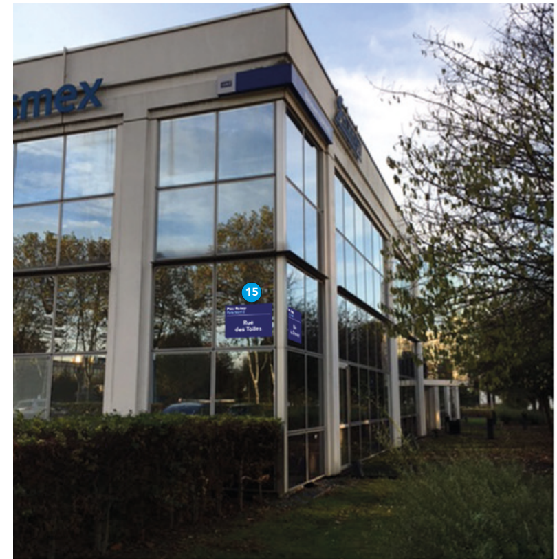
Bâtiment Rubens / Puce N°15 / Rue des Toiles
