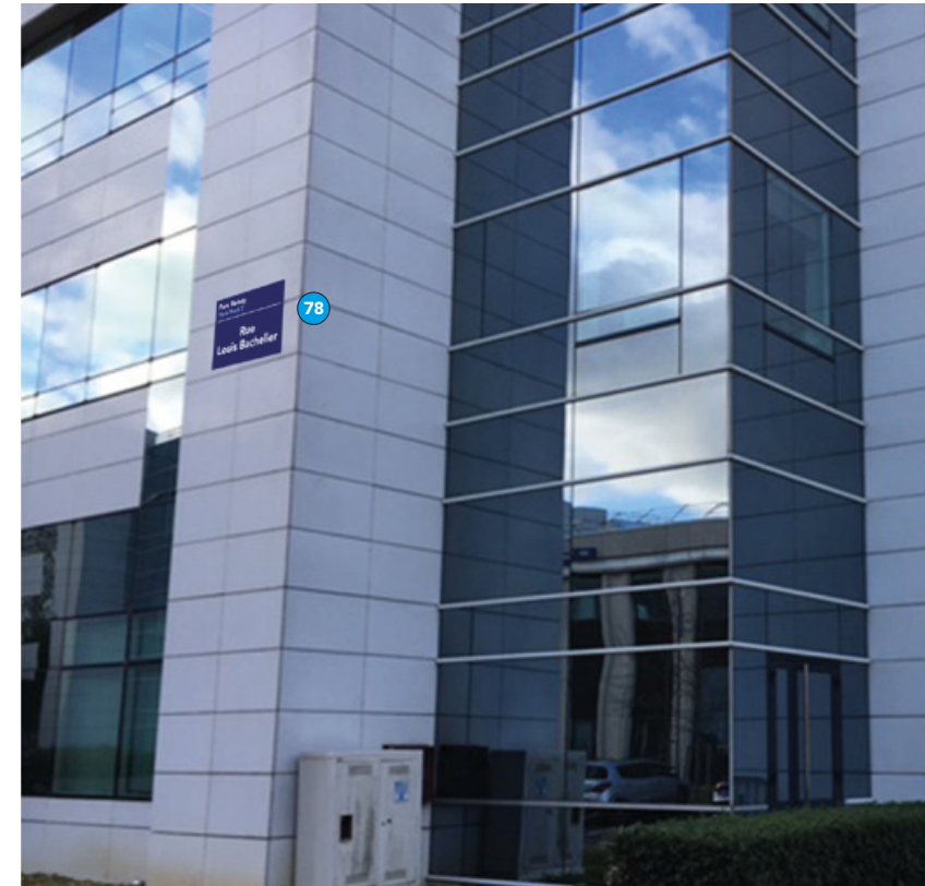
Bâtiment Exelmans / Puce N°78 / Rue des Lumières
