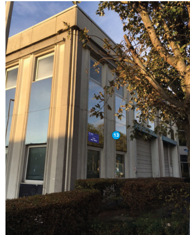
Bâtiment Rubens / Puce N°13 / Rue des Toiles
