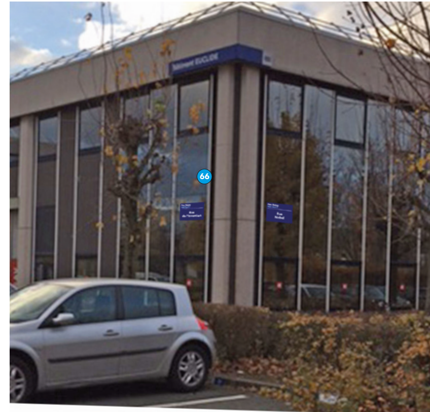
Bâtiment Euclide / Puce N°66 / Rue de l'Invention
