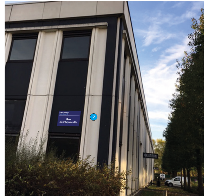
Bâtiment Rodin / Puce N°7 / Rue de l'Aquarelle
