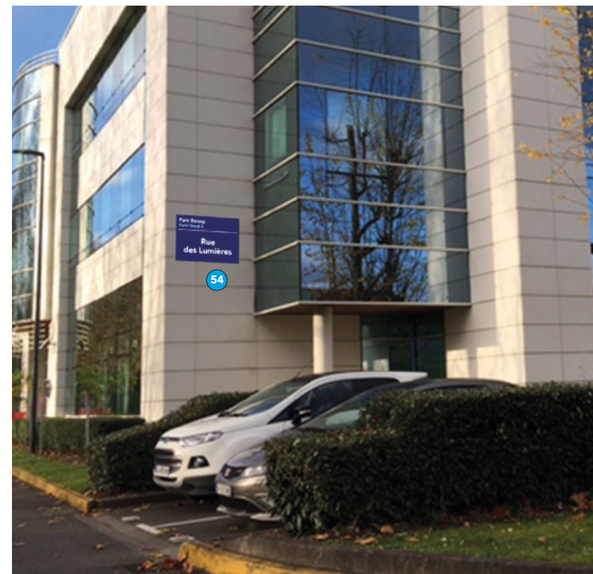
Bâtiment Edison / Puce N°54 / Rue des Lumières
