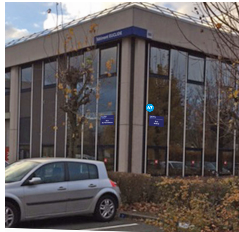
Bâtiment Euclide / Puce N°67 / Rue de l'Invention
