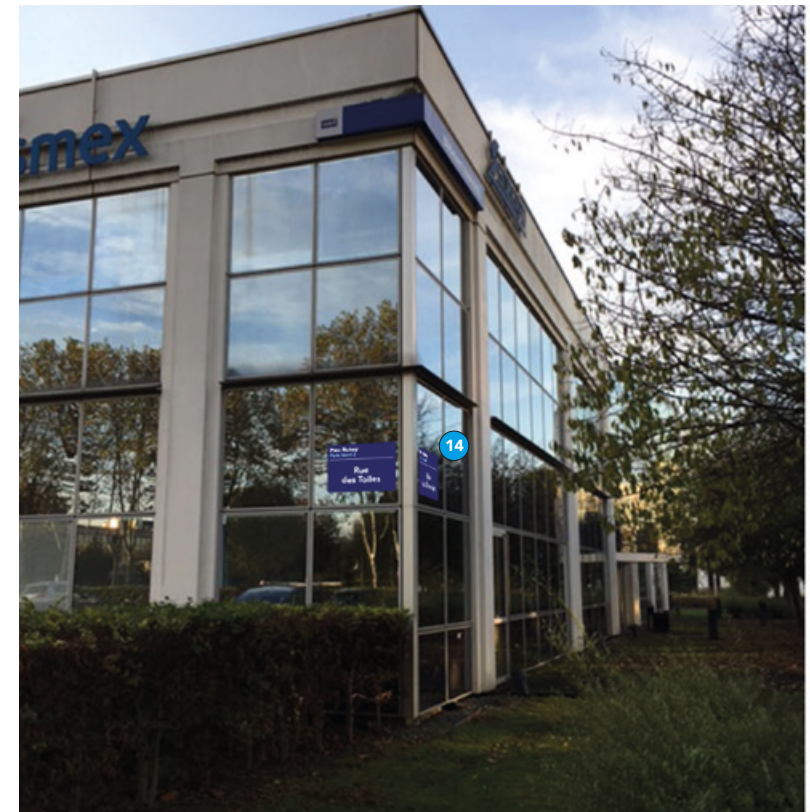
Bâtiment Raphaël / Puce N°14 / Rue du Chevalet
