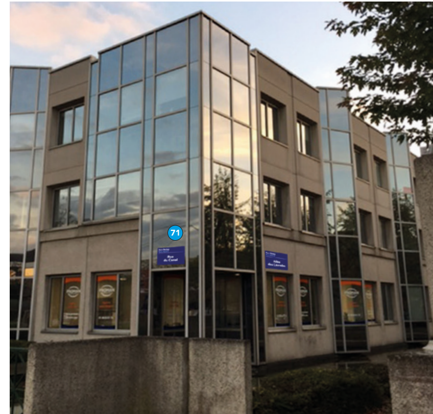
Bâtiment Deltaparc / Puce N°71 / Rue du Canal
