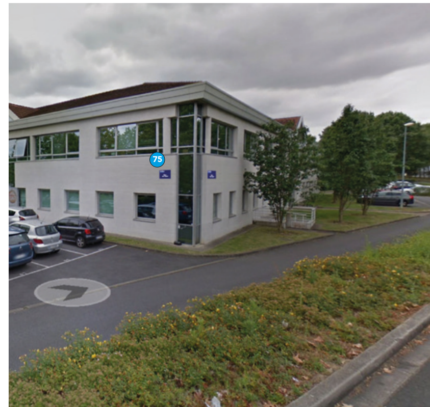
Bâtiment Niagara / Puce N°75 / Rue du Canal
