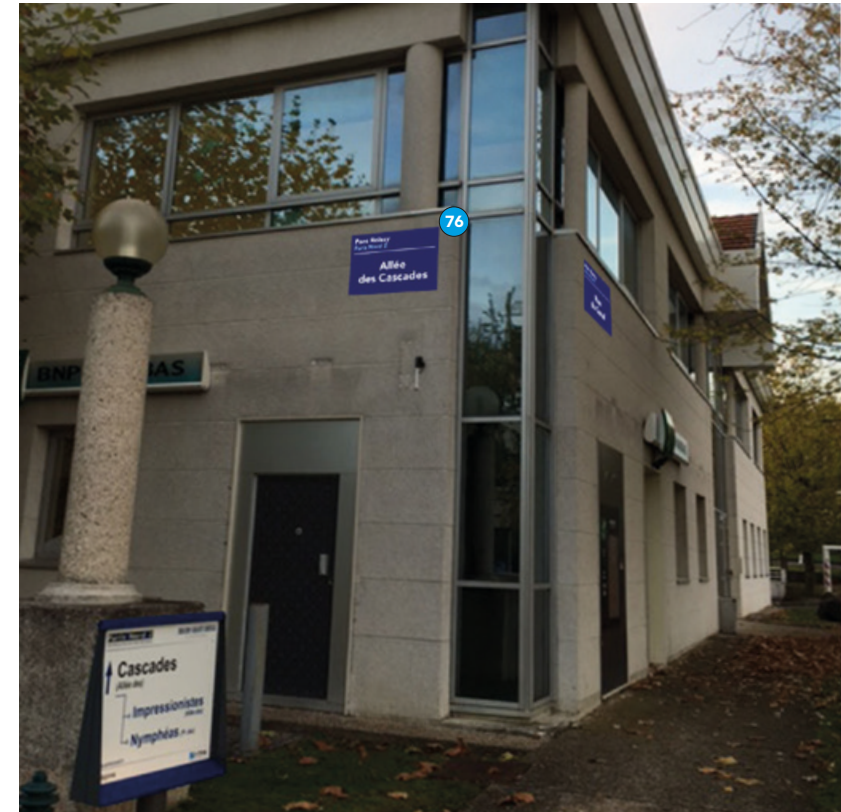
Bâtiment Victoria / Puce N°76 / Allée des Cascades
