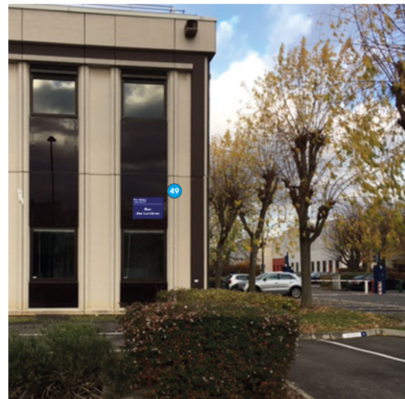
Bâtiment Eole / Puce N°49 / Rue des Lumières
