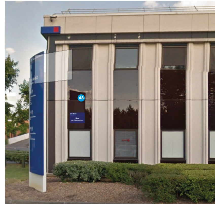
Bâtiment Eole / Puce N°48 / Rue de l'Invention
