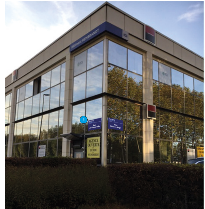
Bâtiment Rembrandt / Puce N°1 / Rue de l'Aquarelle
