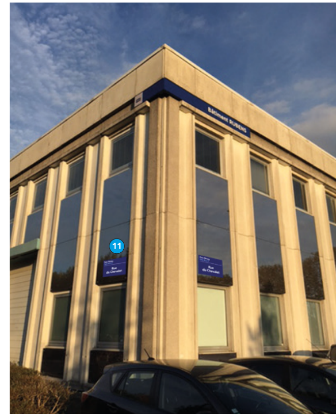
Bâtiment Rubens / Puce N°11 / Rue du Chevalet
