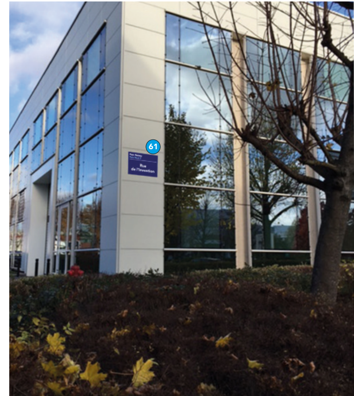
Bâtiment Euler / Puce N°61 / Rue de l'Invention
