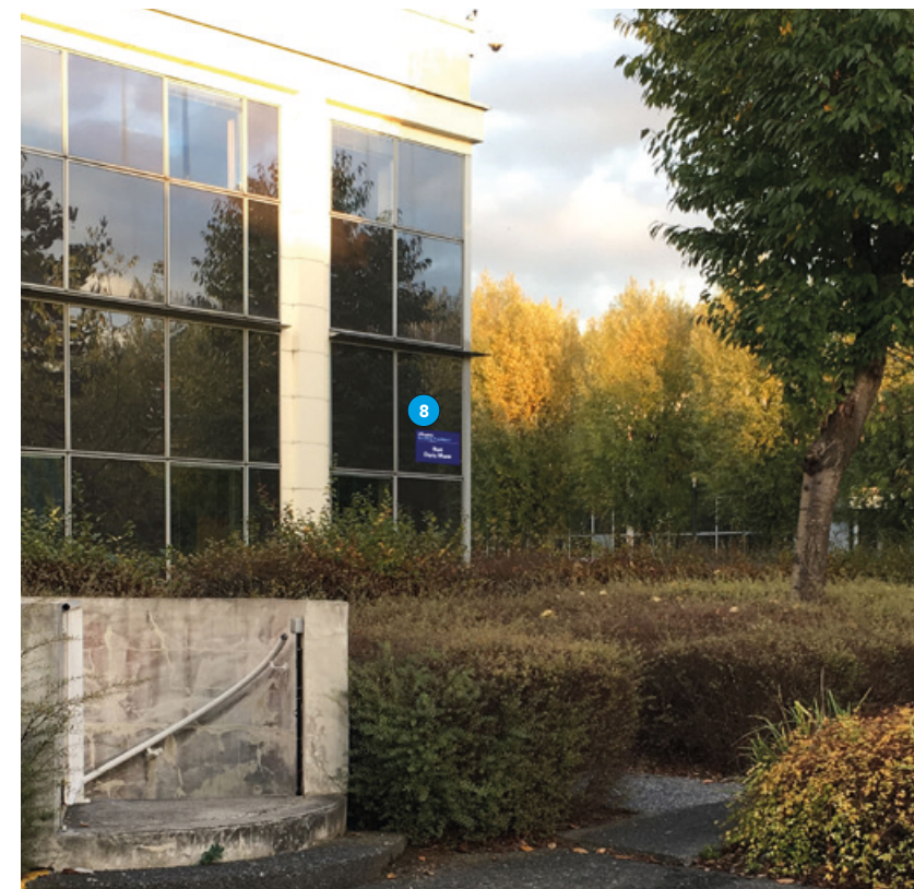
Bâtiment Rembrandt / Puce N°8 / Rue Dora Maar
