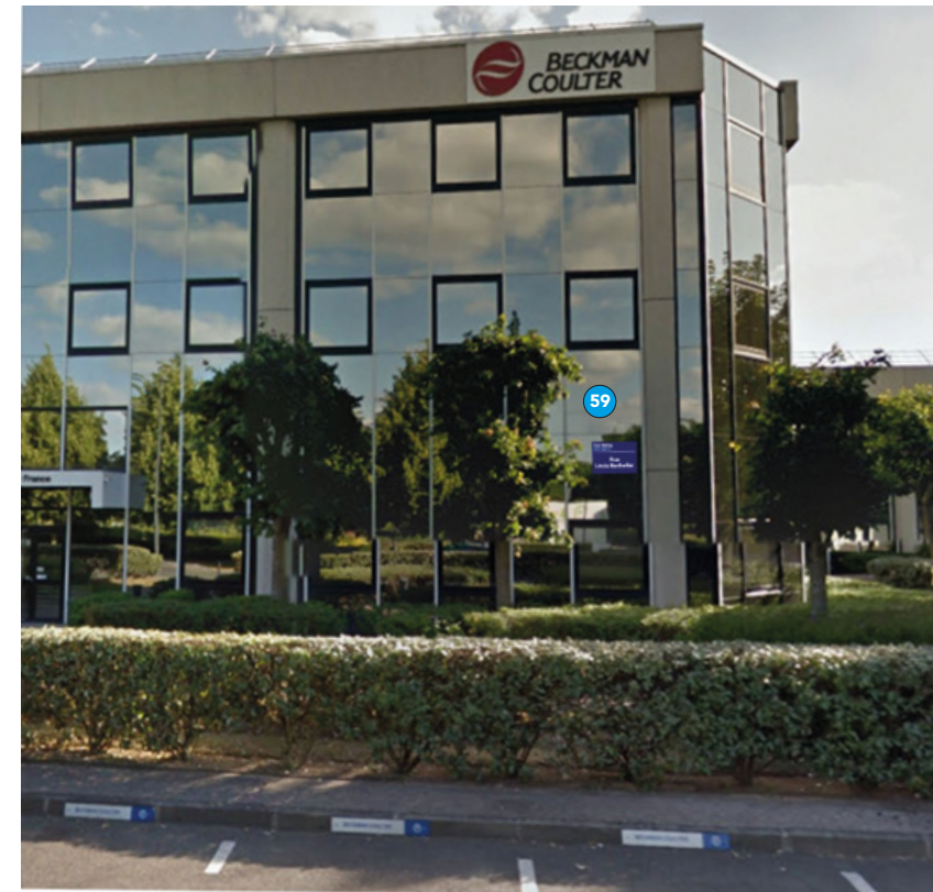
Bâtiment Euclide / Puce N°59 / Rue des Lumières
