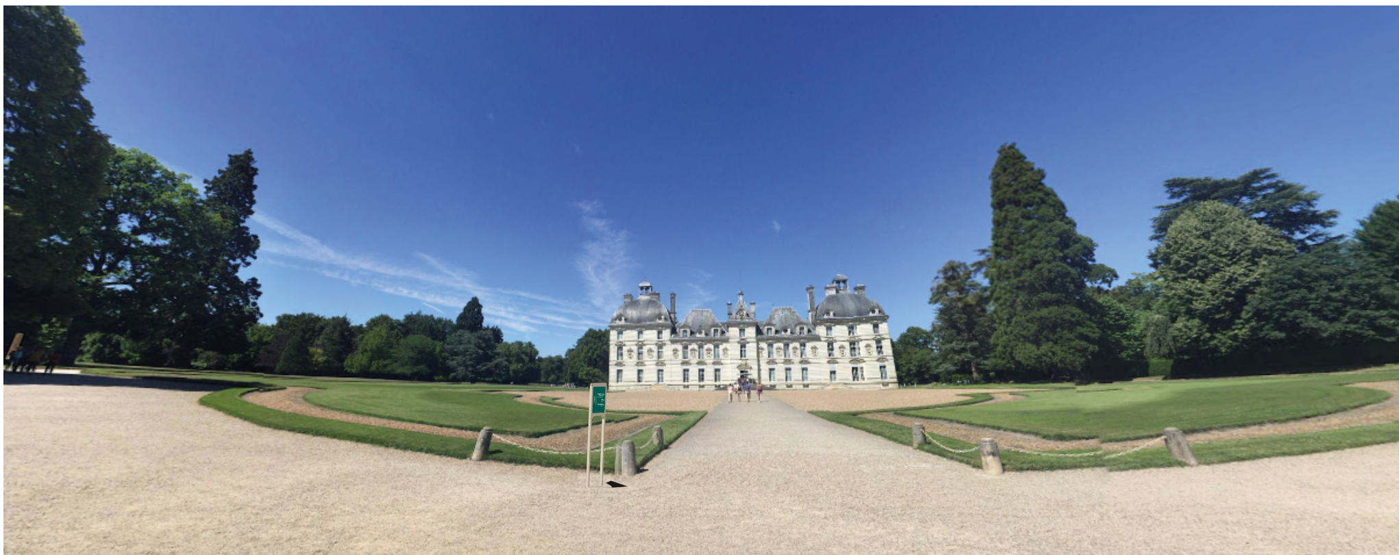
Mise en situation
