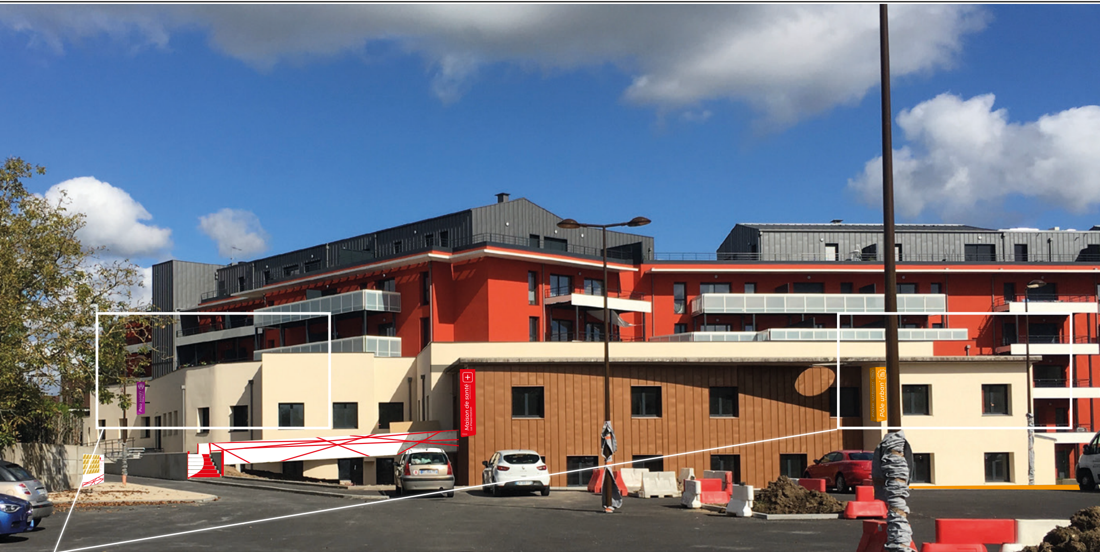
Vue avant implantation des panneaux signalétique
