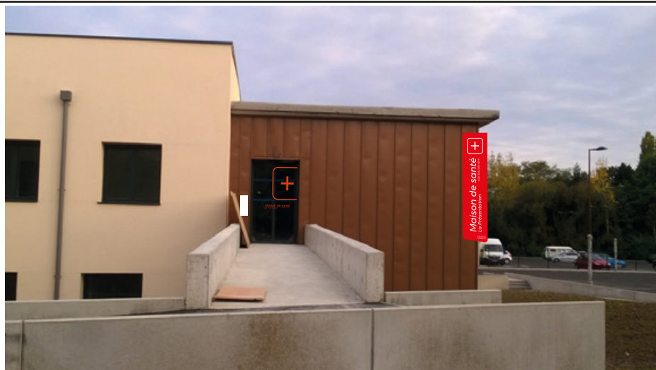
vue entrée MSP
