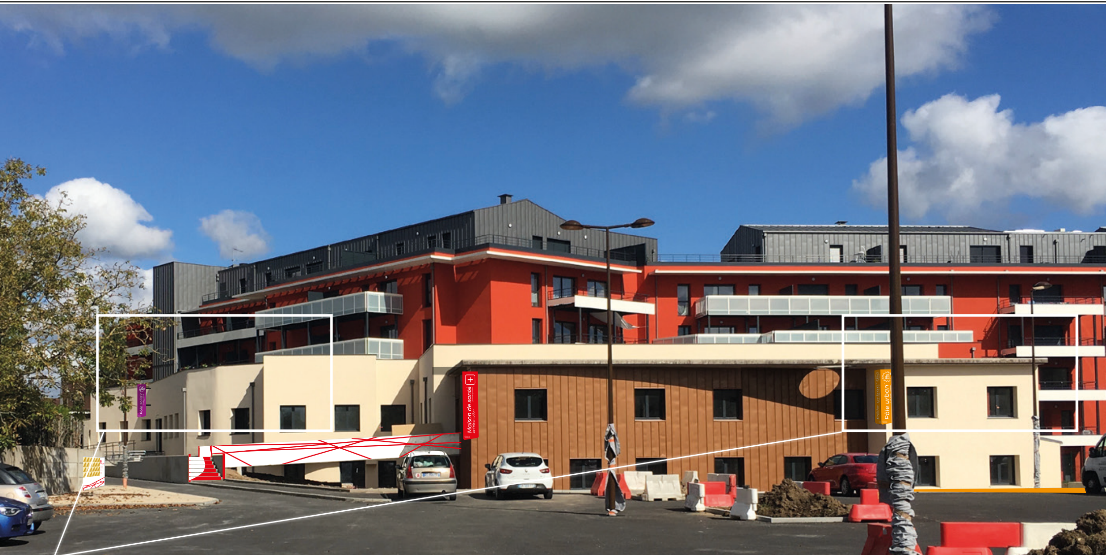
Vue depuis : L'entrée du site
